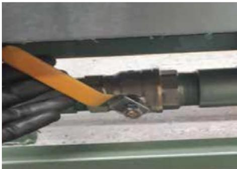
**23** Abrir conducto de gas del tercer nivel del chasis
