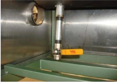
Utilizando regulador de alta 10-080 y con salida de gas a 1/2" (la salida puede variar), conectar niple terminal macho 1/2" a 1/2", reducción campana 1/2" a 3/8" y niple terminal macho 3/8" a 3/8" NPT. conectar a perilla de quemador.
