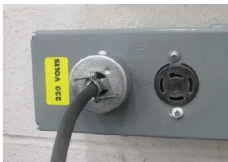
**1** Conectar prensa a toma de corriente de 220 volts
