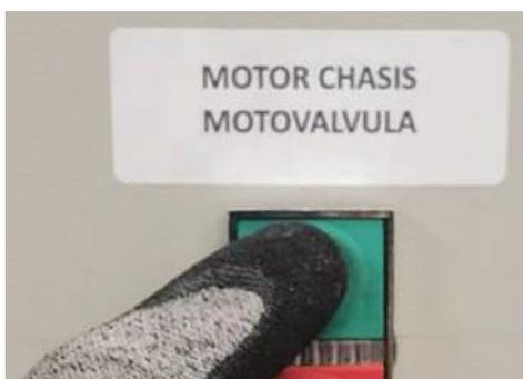
**C** Abrir llaves de paso de toma de gas y oprimir botón de arranque del motor chasis
