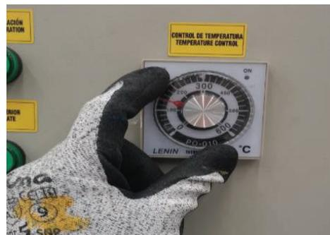
**24** Girar pirómetro a 160°C, indicadores de equipo en operación encenderán
