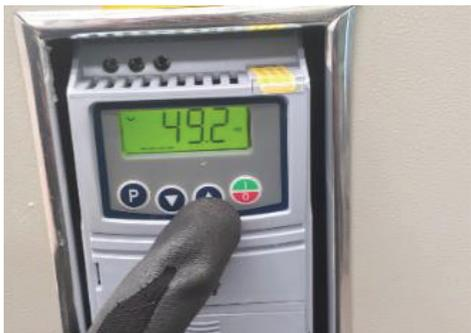
**A** Accionar variador de velocidad, regulando velocidad deseada con flechas arriba y abajo.
