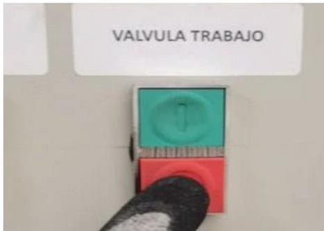
**M** Accionar botón de apagado de válvula de trabajo
